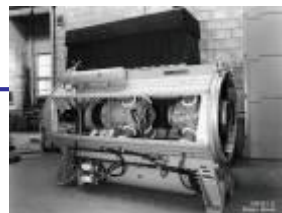
КРУЭ (с элегазовой изоляцией)
